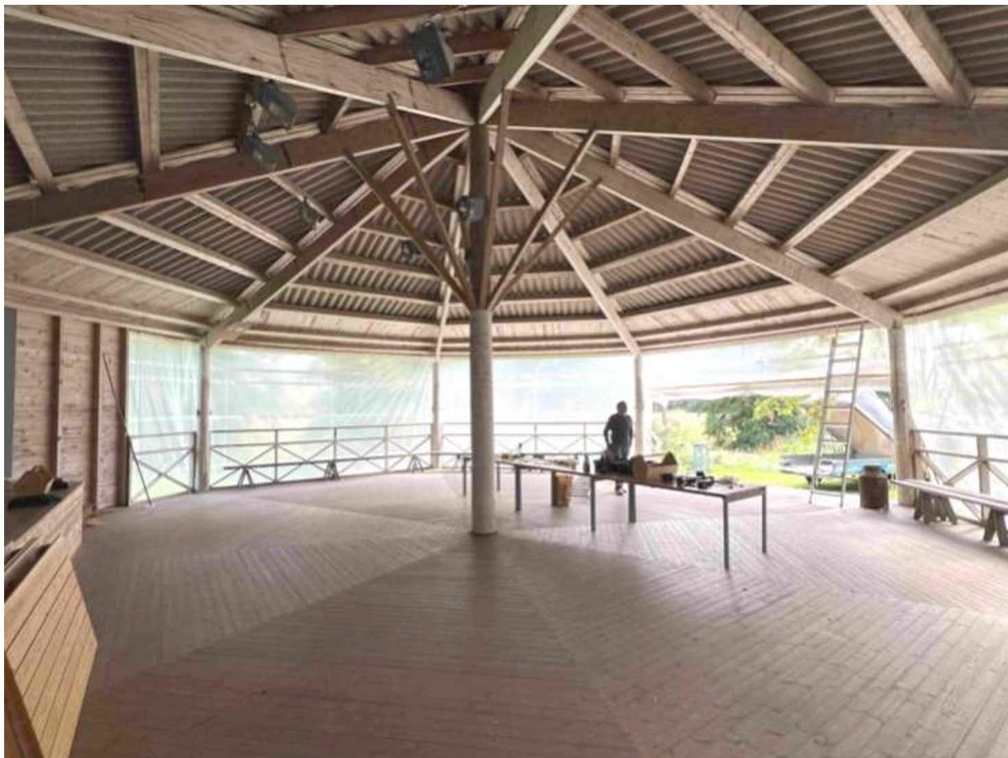
Presenninggardinerna är gjorda av semigenomskinlig plast med glasfiberförstärkning. De kom till god användning redan under sommaren.
