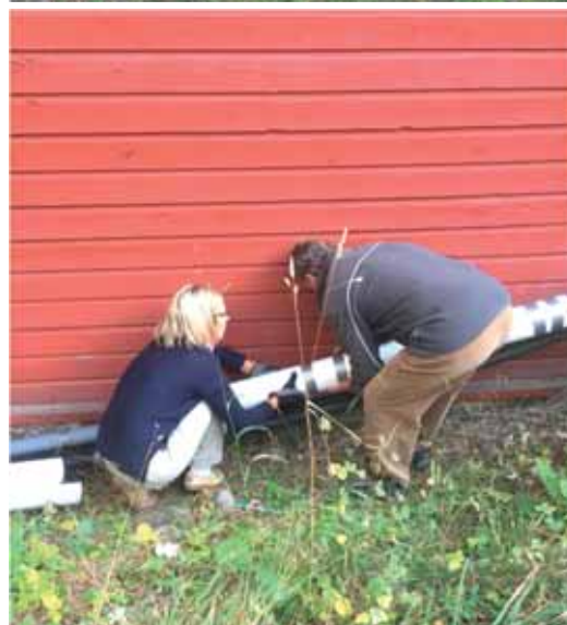
Till höger: Agneta och Johan Brenner installerar värmeisolering på köksrören.
