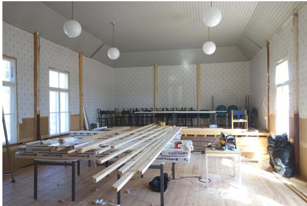
20.4.2013. Festsalen är tapetserad och panelerna väntar på målning och montering. Golvet skall också ännu behandlas, foderlister monteras och andra avslutande jobb göras.
