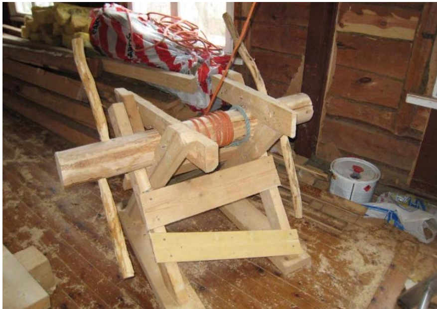
Än lever traditionen! Den här nygamla vinschen visar hur skickligt Erik och Elmer löste problemet med att lyfta de tunga stockarna under reparationsarbetet.
